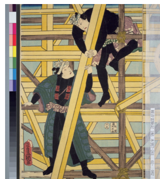
作業中のとび職
